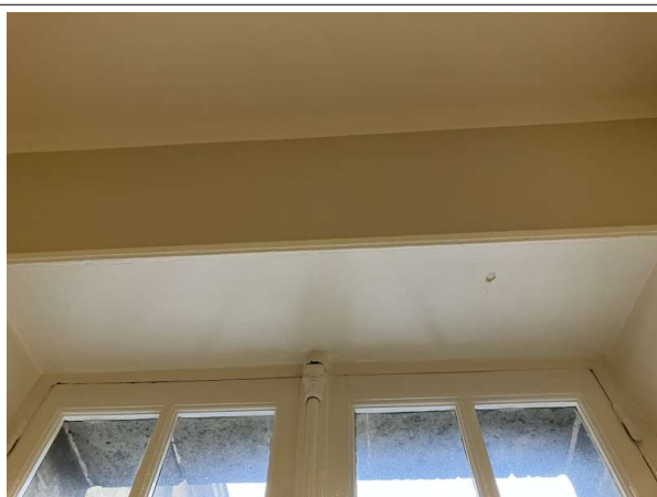
Prélèvement - P136 : Patio 2 / R+1 / Façade Nord / Local 174 - Enduit- (Absence d'amiante)
